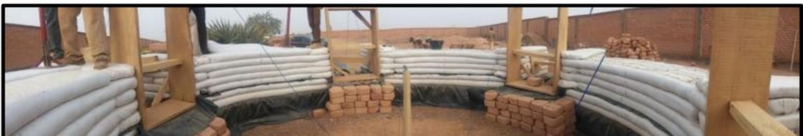
5.- Construcción de la fosa séptica para el saneamiento de la zona de viviendas del TMC. Drenaje de la zona de construcción para evitar las inundaciones en la época de lluvias.
