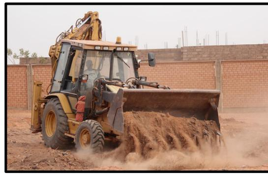
4.- Inicio de la primera fase de construcción del primer edificio de la zona de vivienda en el TMC. En colaboración con los arquitectos de la Universitat de Lleida UDL y con la técnica de construcción Superadobe (Earthbag).
